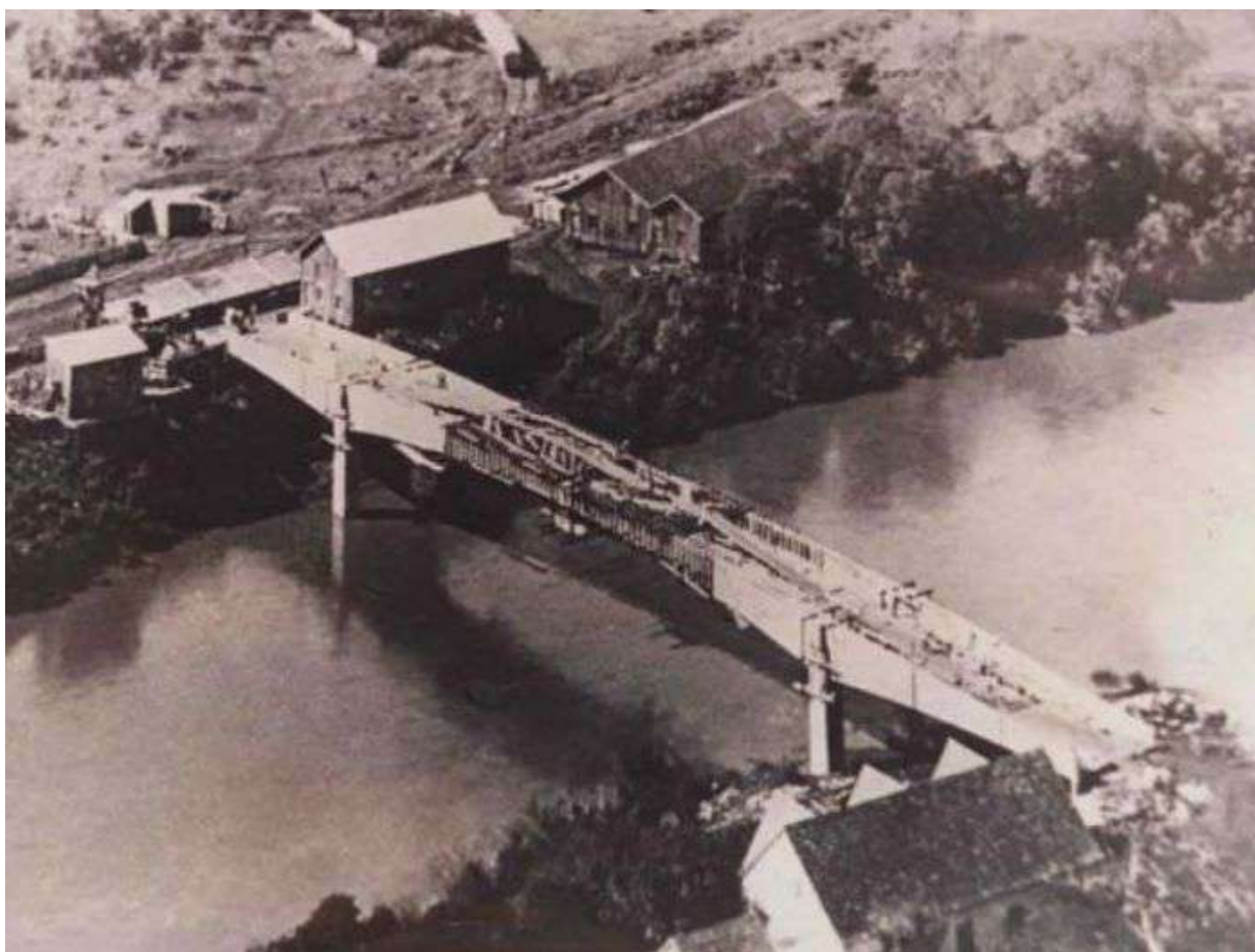
Figura 35 - Vista aérea da Ponte Emílio Baumgart.
