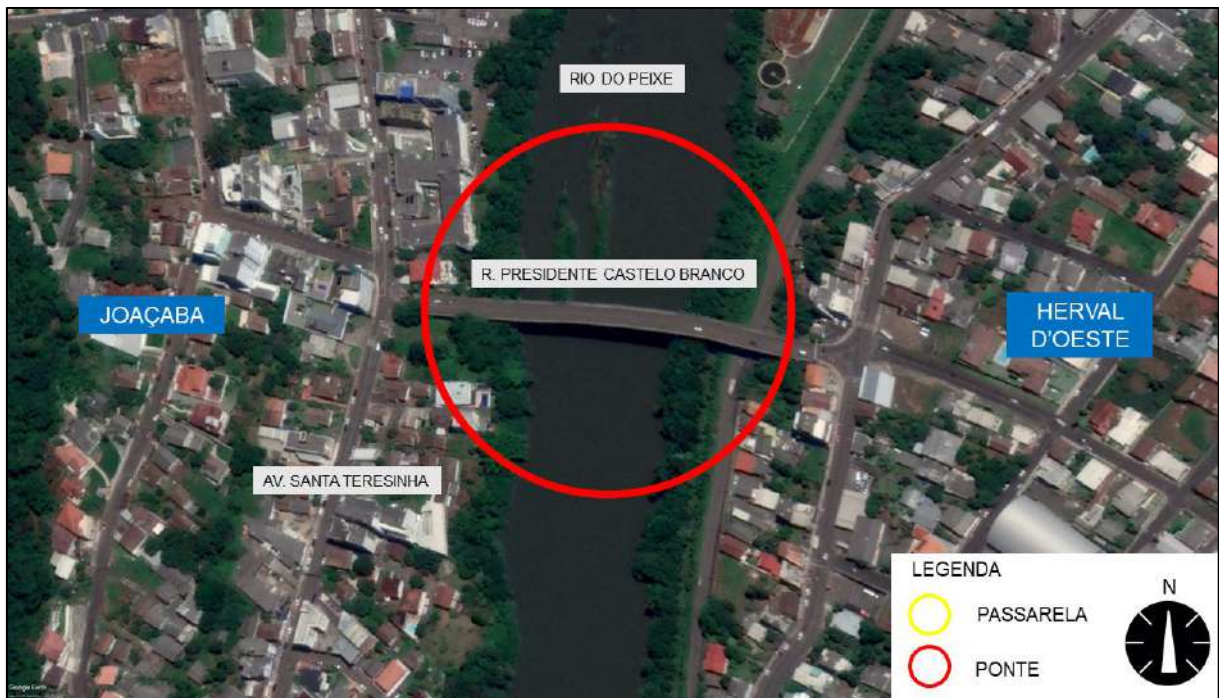
Figura 15 – Ponte sobre o Rio do Peixe, entre os municípios de Joaçaba e Herval d'Oeste.
